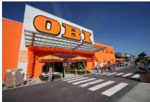
HEININGER STRASSE, 73037 GÖPPINGEN
